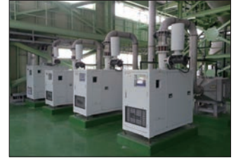
Sudokwon Landfill Site (NX150), Korea
